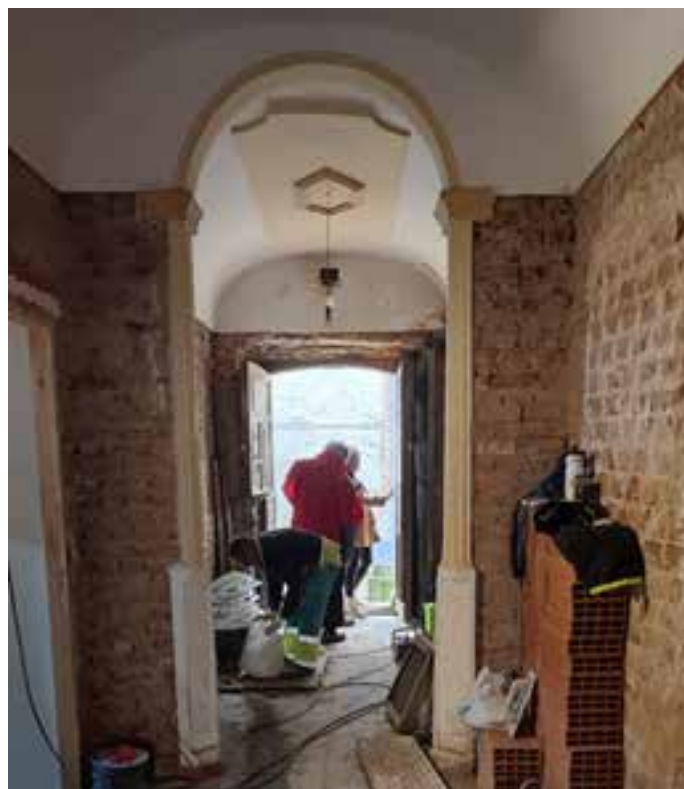
Construcción albergue de Campolugar
