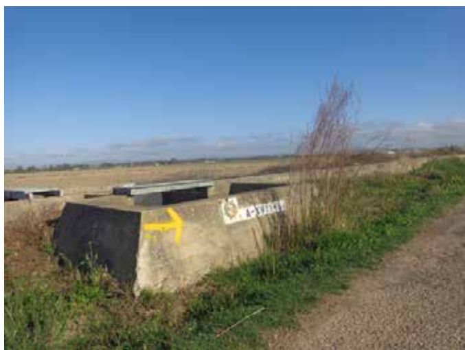
Señalización Camino de Regadío
