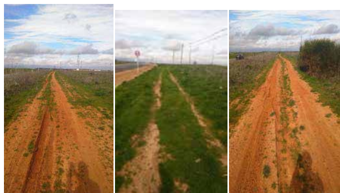
Estado actual del Camino
