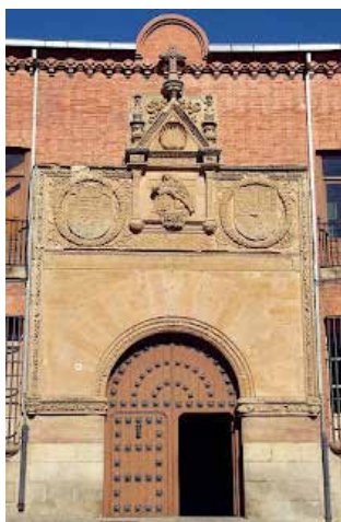
Fachada del Hospital de la Piedad.
