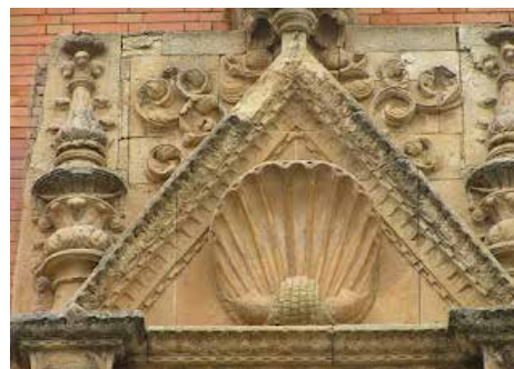
Frontón con venera en la fachada del Hospital de la Piedad.
