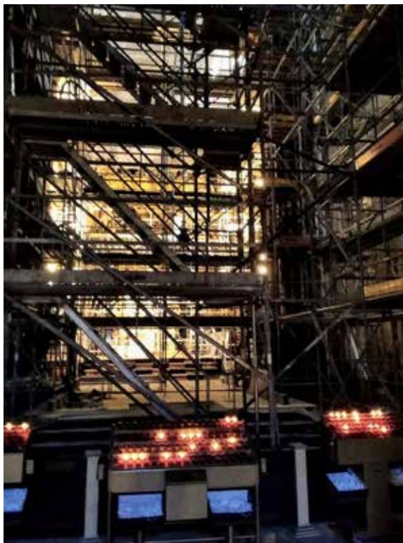
Y el altar mayor sólo se intuye entre el cruce de cables y andamios que han instalado para recuperar las pinturas de la bóveda.
