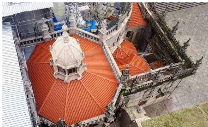
En la cubierta de la capilla del Pilar han colocado teja en lugar de lajas y han asegurado que se ventile el interior y evitar humedades de ese modo.
