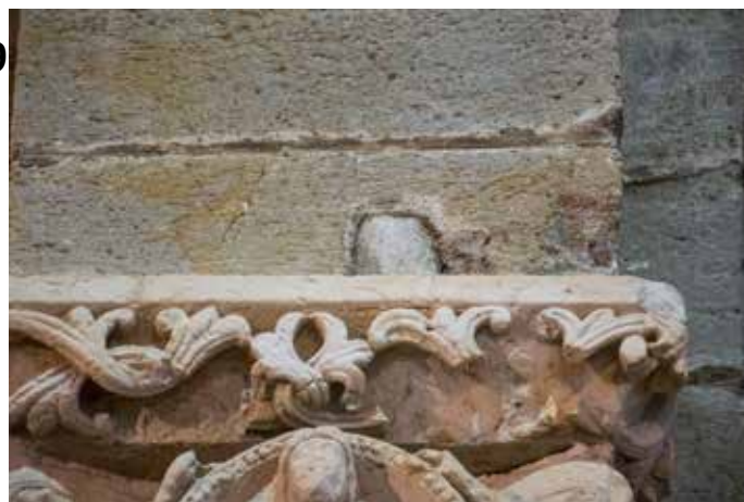
ASENTAMIENTO PARA EL RIEL DE CORTINA EN EL ARCO DEL ALTAR
