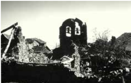
FONCEBADON: Pueblo en ruinas y campanario en riesgo de desplome. (1.988).
