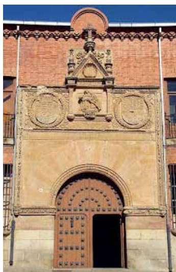
Fachada del Hospital de la Piedad.
