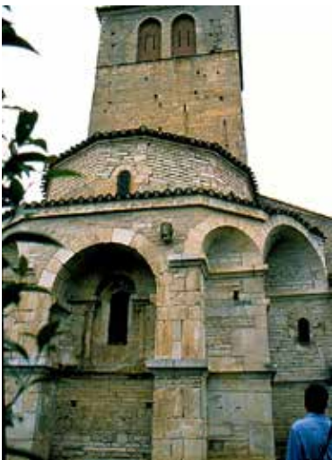
ST. JUST-DE-VALCABRÈRE: Exterior de la cabecera del templo y torre. (Foto A.P.).
