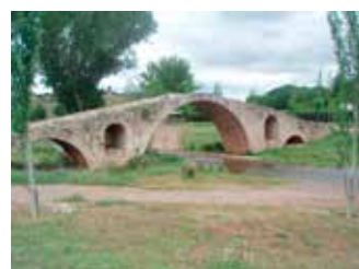
Luco de Jiloca, puente romano
