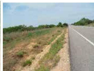
Foto 17. Camino sin desbrozar y N-525. Santa Marta de Tera.
