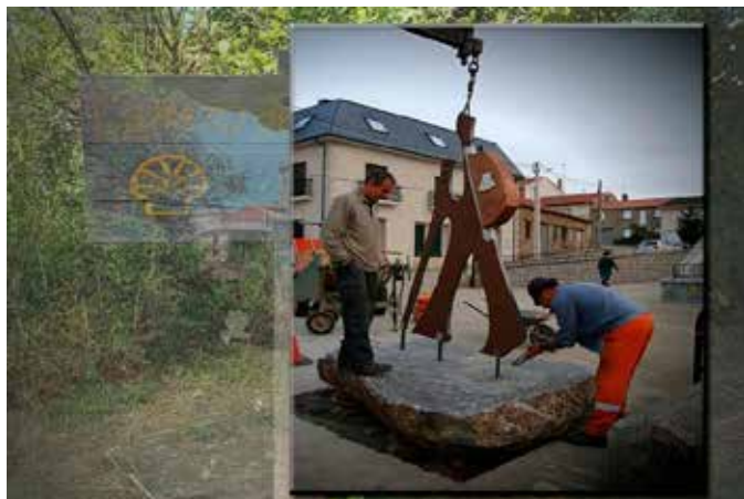
Después la escultura fue anclada a la piedra mediante unos pernos de anclaje para mayor sujeción de la pieza.
