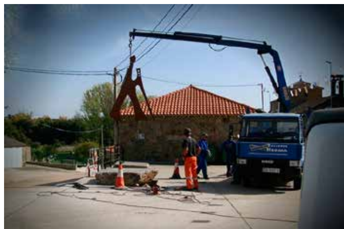
Se picó el suelo para que la piedra quedara empotrada en el hormigón, se insertaron los puntos cardinales en el suelo.
