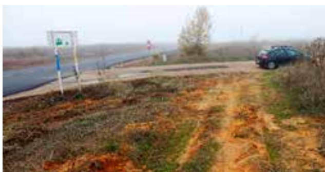
El camino, una vez rebasado el enlace clausurado, desemboca en el Camino de los Cascajos.
