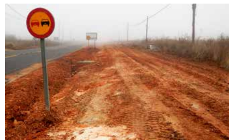
Estado del camino cuando se realizó la visita (Dic. 2016)
