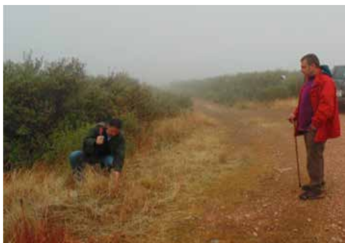
Instalando una marca donde luego irá un poste de señalización
