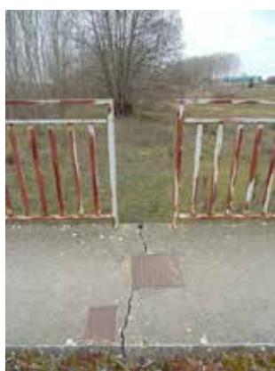
Vista de los huecos de la barandilla desde el soto y desde el puente.
