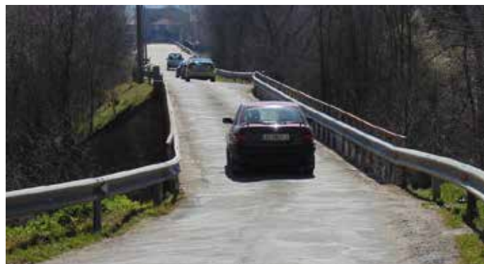
Vista general del puente tras la reparación.
