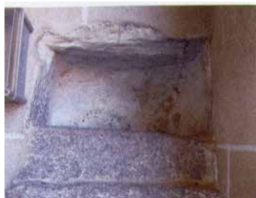
Una de las dos cunas en los muros interiores
